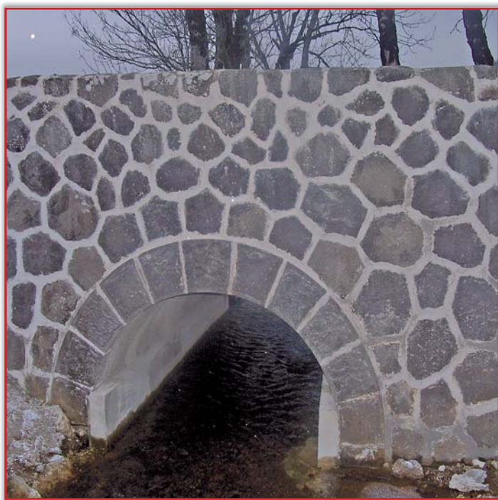
La réfection complète de deux ponts au Trador en 2009, a répondu à des soucis de sécurité, en alliant intégration paysagère et sauvegarde du patrimoine.
